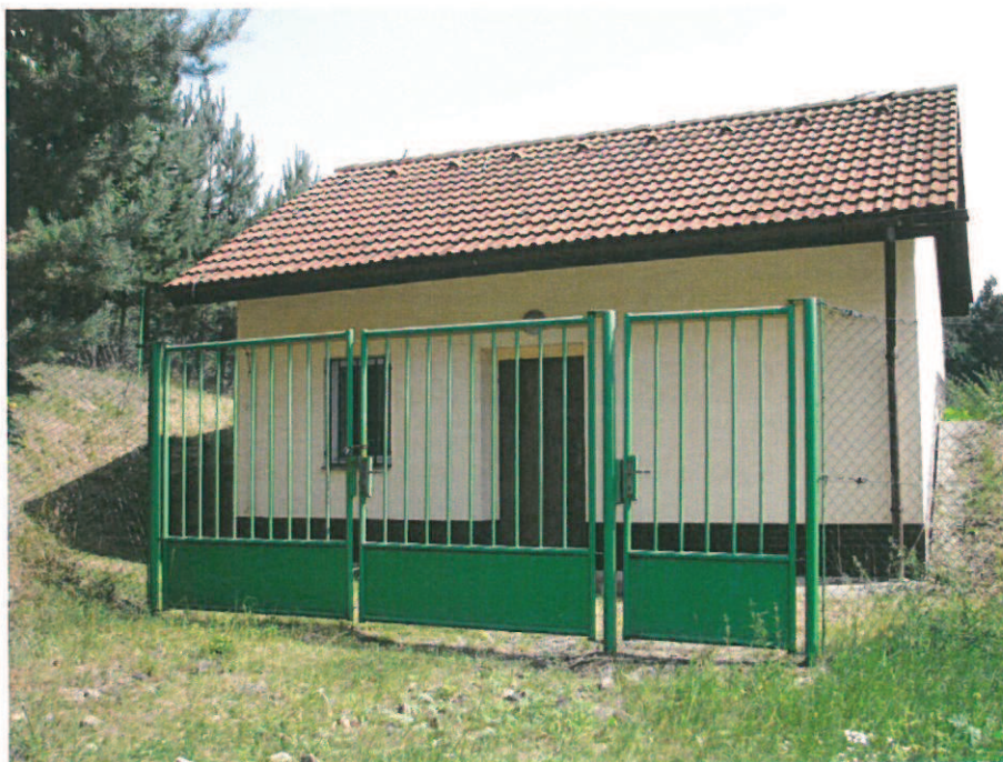
Foto 1 – Vodojem Podkopná Lhota
